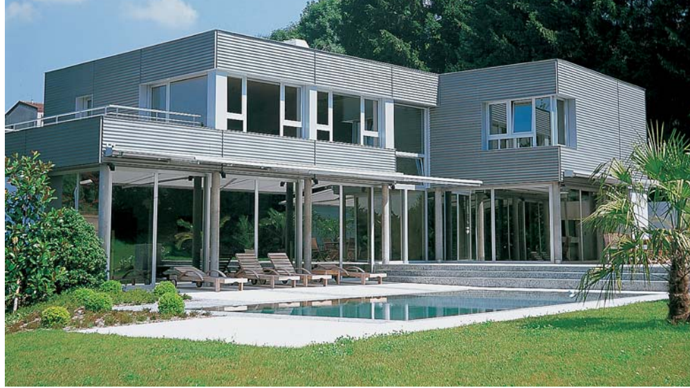
Arch. Böge Lindner Architekten - QUARTZ-ZINC®
